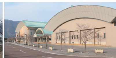
体育館・格技場
