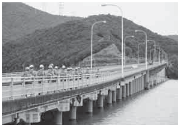
【青戸の大橋を移動する様子】
