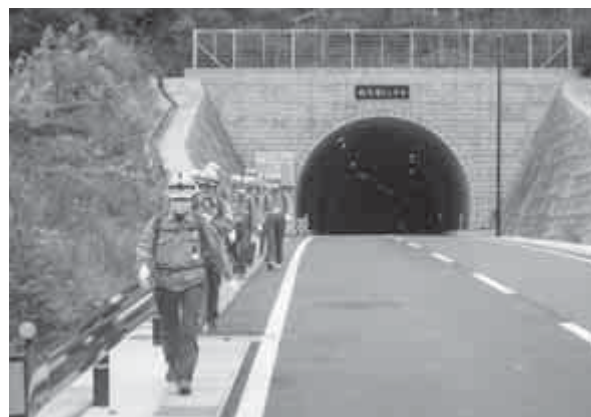
【新大島トンネルを移動する様子】
