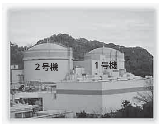
【大飯発電所1,2号機】
