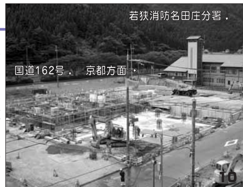
名田庄総合施設工事風景
