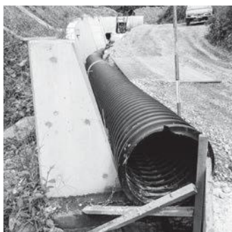
仮設導水管の様子
