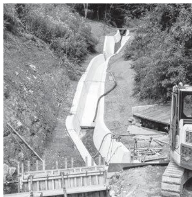
畑村川河川改修工事護岸改良
