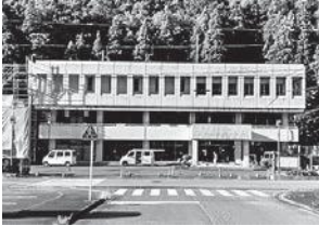
改装工事中の「あきない館」(旧名田庄総合事務所)
