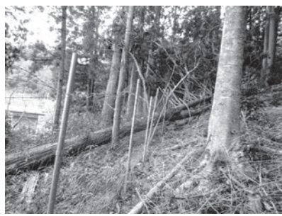
倒木により破損した金網柵
