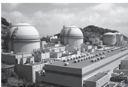
1・2号機が廃炉となった関西電力(株)大飯発電所
