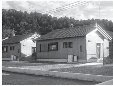
完成間近の長井町営住宅
