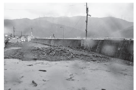
台風21号通過後の状況
