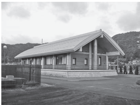
し尿処理施設が併設される名田庄東部浄化センター
