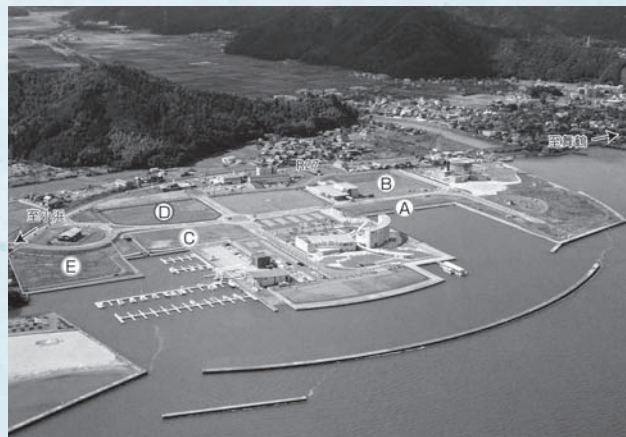
企業誘致が進められているうみんぴあ大飯地区
