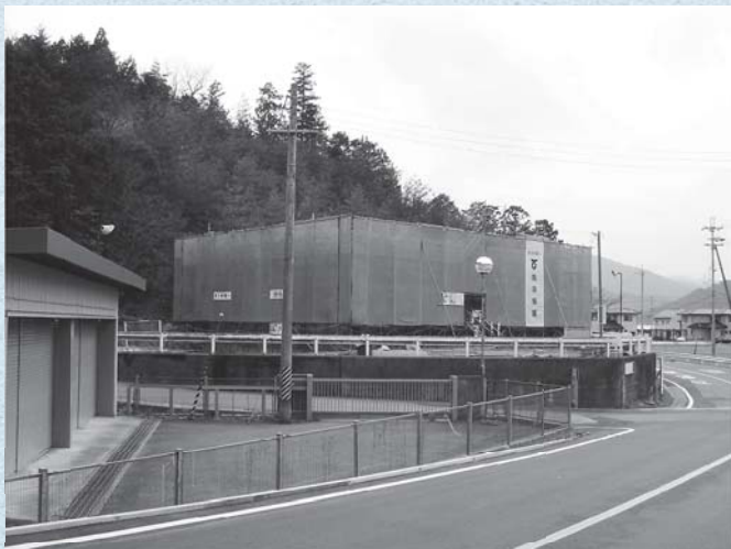
建設が進む本郷配水池
