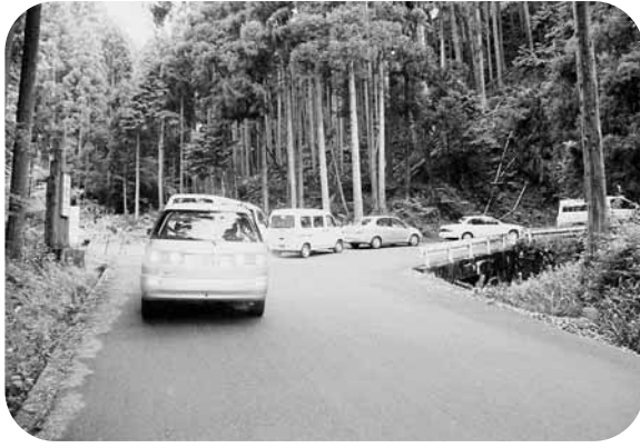
県道坂本高浜線幅員狭小区間
